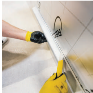
17. Mittaa paneelin alapuolelle tulevan sokkelilaatoituksen yläreunan korkeus. Laatoitus kiinnitetään suoraan eristelevyn pintaan.
