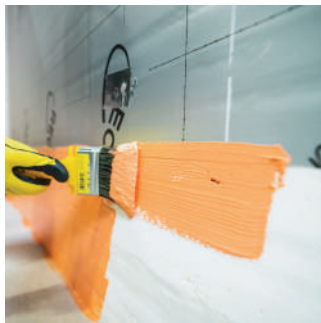
19. Sivele eristeen pintaan tartunta-pohjuste ja vedeneriste valmistajan ohjeen mukaisesti. Laatoita sokkeli normaalisti eristelevyn pintaan.
