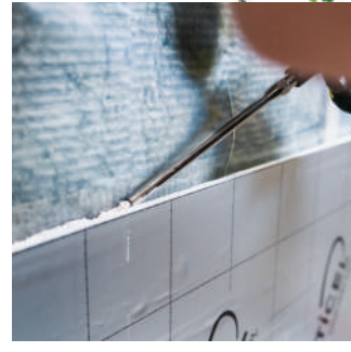
12. Pursota saumavaahtoa eristelevyn ponttiin. Sauman ja nurkkiin riittää täytteeksi ohut kerros saumavaahtoa.
