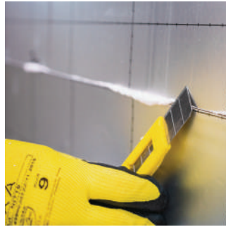
13. Asenna seuraava levy, kun pontissa on saumavaahtoa. Trimmaa ylipursunut ja kuivunut saumavaahto pois katkoteräveitsellä. Saumojen trimmaamisessa on tärkeää noudattaa saumavaahtovalmistajan kuivumisaikoja.
